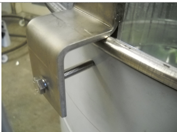
Fissare, come da foto 2, la staffa per galleggiante al bordo del maturatore o della vasca di decantazione.
